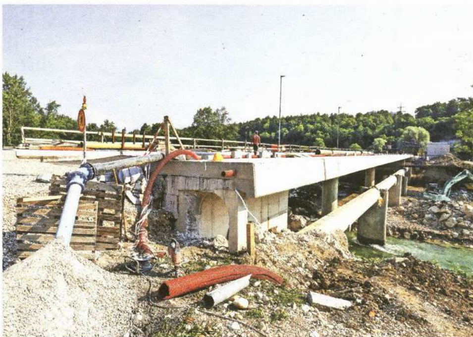
Mestna občina Kranj nadaljuje gradnjo novega mostu čez Savo pri nekdanji Planiki ter pripadajočih cestnih povezav in komunalne infrastrukture. / Foto: Tina Dokl
